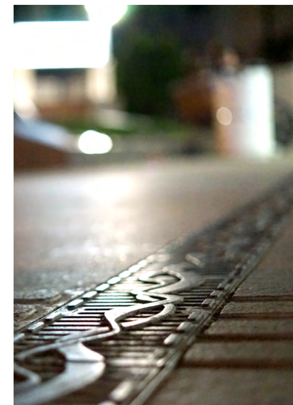
ACO DRAIN® Multiline Seal In με προστατευτική ακμή από γαλβανισμένο είτε ανοξείδωτο κάλυβα
